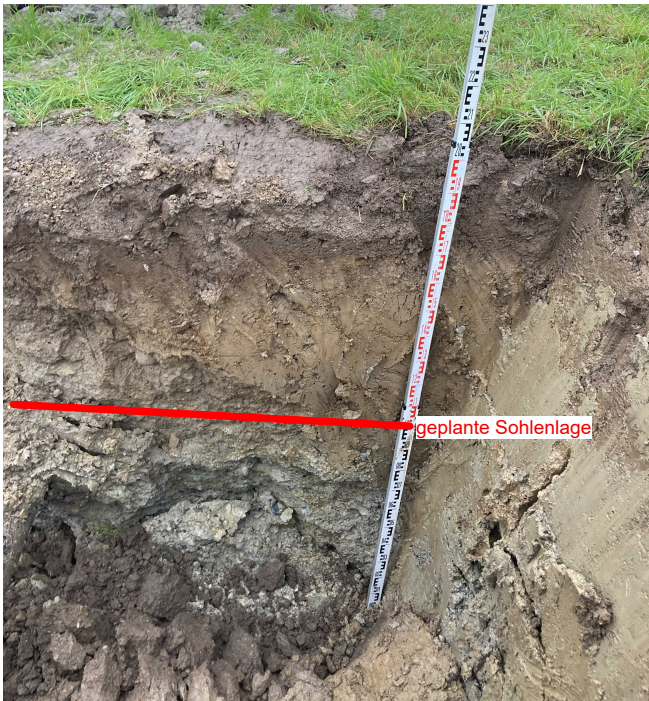
Sondagenschlitz 2 geplante Sohlenlage = -1.0m
