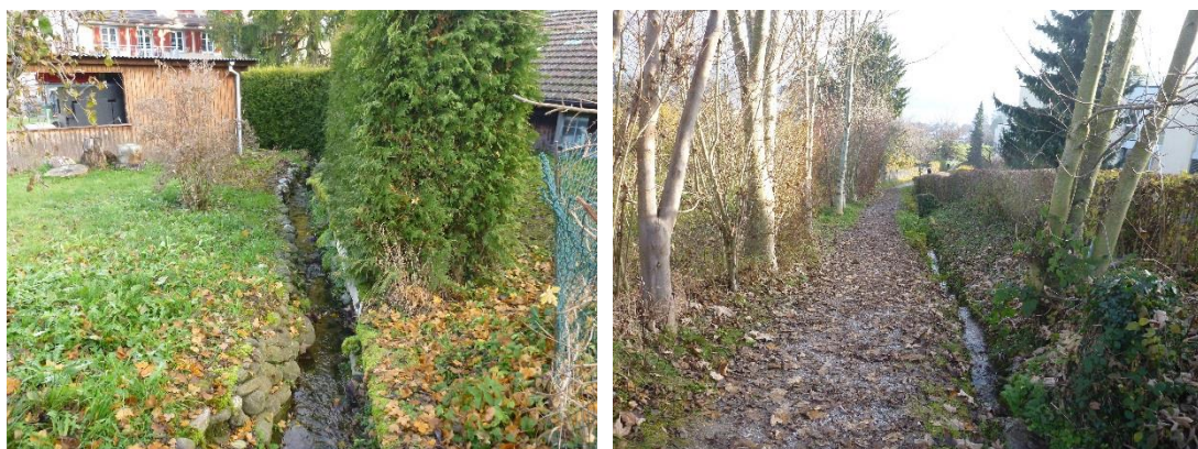
Abbildung 20: Grenzbach Thalwil am künstlichen / naturfremden Abschnitt Gre-05, Blick in Fließrichtung. Rechts: Der Grenzbach Thalwil entlang des Vorderen Mettliwegs, im Abschnitt Gre-09, Blick in Fließrichtung
