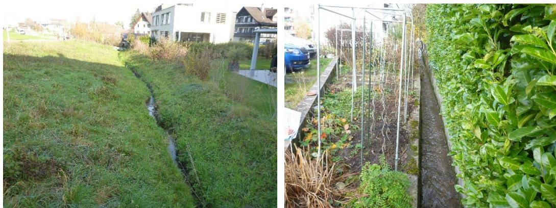
Abbildung 23: links: Der Butzenbach entlang der Weidstrasse, im Abschnitt But-10, in der Kernzone, rechts: Butzenbach am künstlichen / naturfremden Abschnitt But-06, Blick in Fließrichtung
