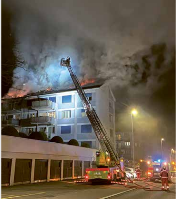
Dachstockbrand vom Mittwoch, 9. Februar 2022 an der Einsiedlerstrasse 12, Horgen. Foto: Kantonspolizei Zürich.
