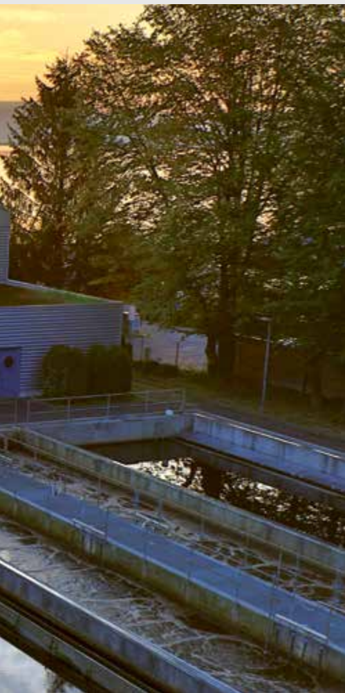
Abwasser- reinigungsanlage Horgen- Oberrieden.
