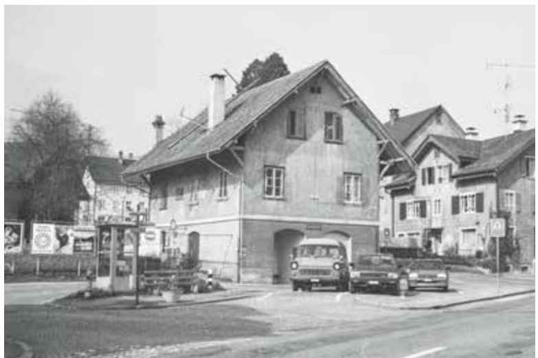
Telefonkabine bei der Bushaltestelle an der Bergwerkstrasse 1, 1987.
