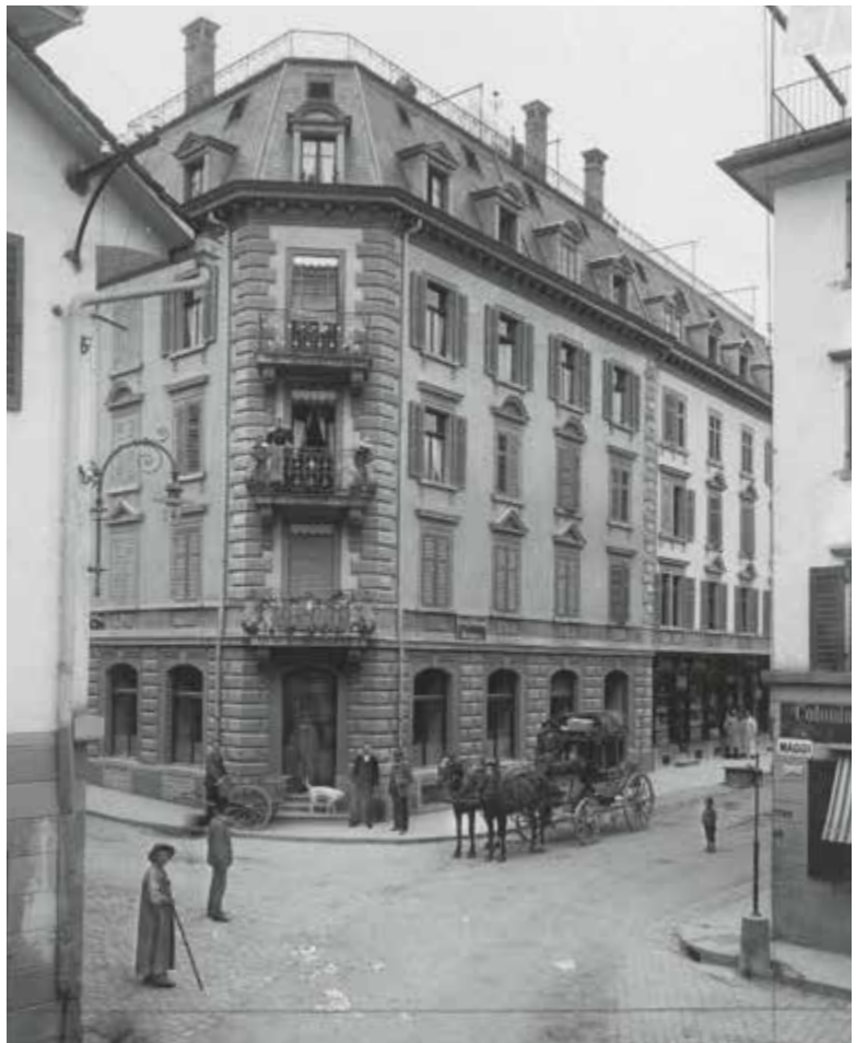
Am 1. Mai 1894 bezog die Post mit Telegraf- und Telefondienst den Neubau an der Seestrasse 154, um 1900.
