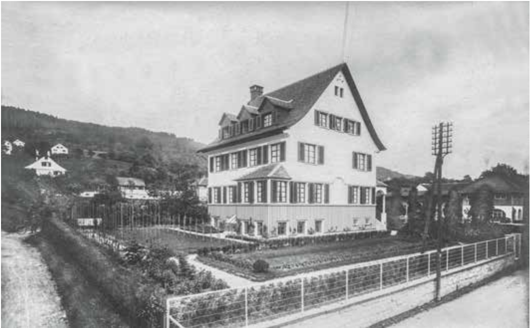
Freileitungsmast für Telefondrähte bei der Villa von Gärtner Carl Trüb an der Seegartenstrasse 61.
