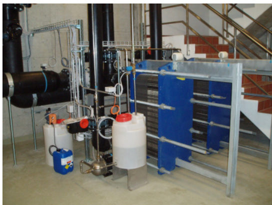
(Wärmetauscher Kalte Fernwärme)
