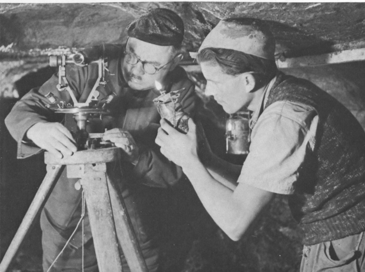
Bergwerksleiter Schneider bei Vermessungsarbeiten im Stollen. Auch für diese Präzisionsarbeit stand nur das Licht der Grubenlampen zur Verfügung.
