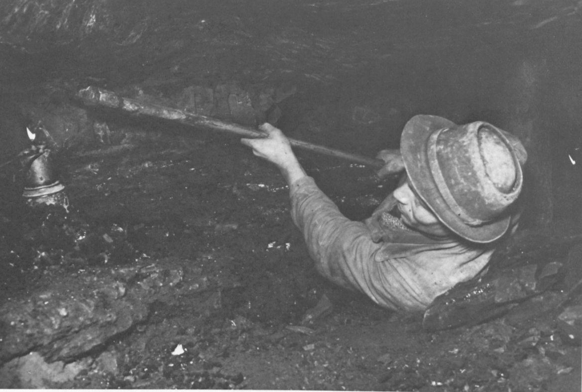
Häuer im Abbau (Linkshäuer), welcher liegend mit der Schrämhauhe das Kohleflöz freilegt.
