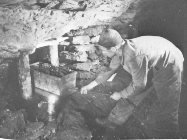
Ein Bergmann zieht die durch seinen Kameraden im Abbauschlitz mit Kohle gefüllte Kiste in den Abbaustollen, um sie in den bereit stehenden Wagen zu leeren.
