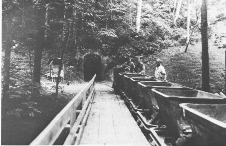
Leerer Materialzug vor der Einfahrt in den Förderstollen Gwandlen II.
