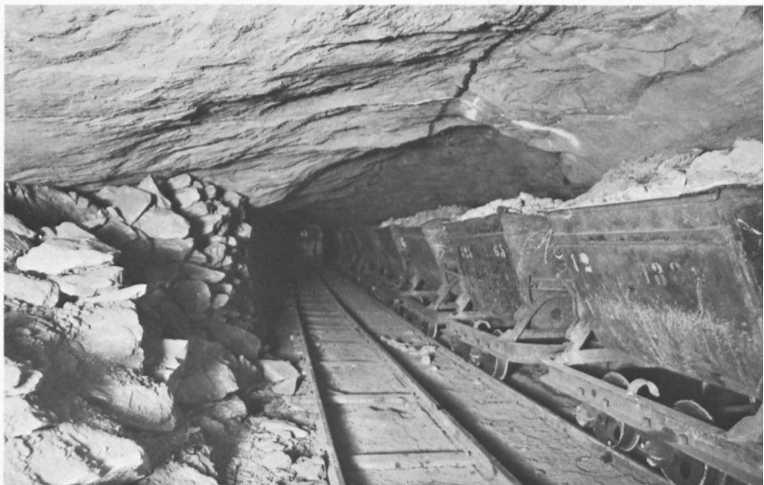
Materialzug, mit Ausbruch gefüllt, bereit zum Abtransport auf die Deponie.
