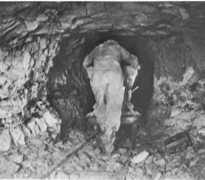
Eine mühsame Arbeit ist es, die schwer beladenen Wagen durch die engen Querstollen zum Hauptstollen zu schieben.
