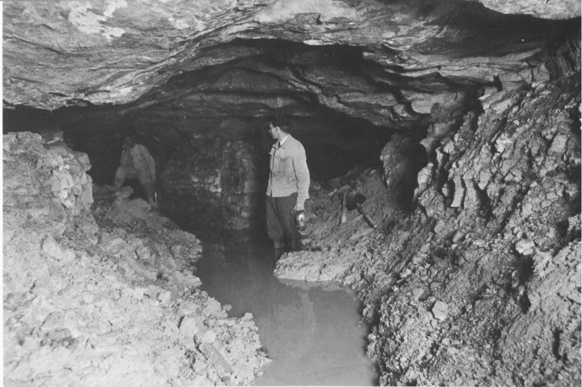
Wassereinbruch in einem Stollen
