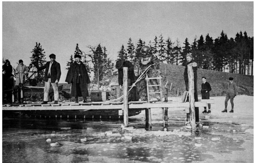
Taucher beim Steg - für Reparaturarbeiten am Grundablass, 1929
