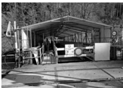
Sanierung der denkmalgeschützten Fachwerkbrücke Sihlwald im Winter 2016/17. Für die Sanierung der Eisenträger muss die Baustelle eingehaust werden.
